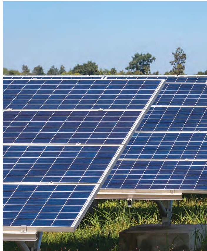
REALIZZAZIONE CAMPO FOTOVOLTAICO
