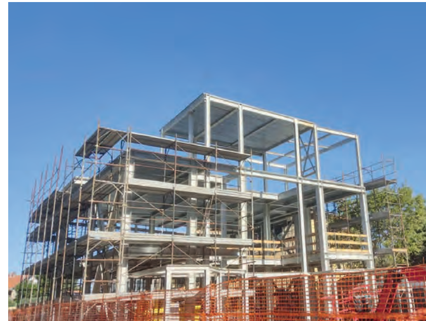
CANTIERE GAMBASSI TERME
