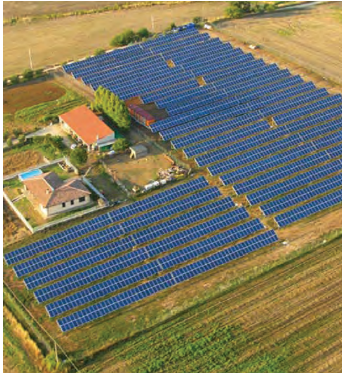
REALIZZAZIONE CAMPO FOTOVOLTAICO
