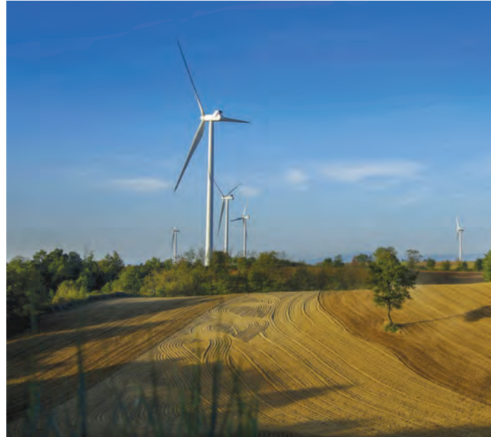
COSTRUZIONE IMPIANTO EOLICO
