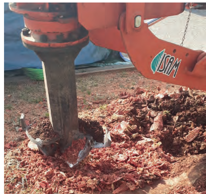
RIMOZIONE DELLE CEPPE
